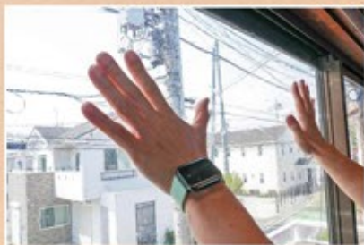
窓ガラスフィルム施工 福窓
