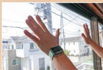
窓ガラスフィルム施工 福窓
